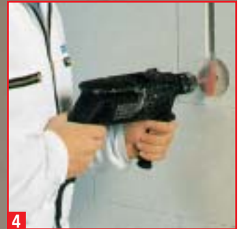
4 Bohren von Schaltdosen
