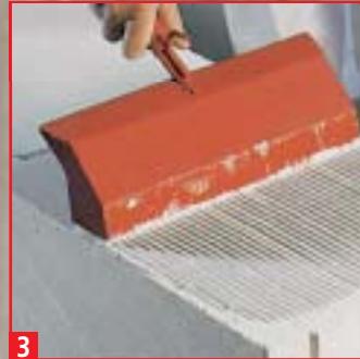
3 Auftragen von Dünnbettmörtel
