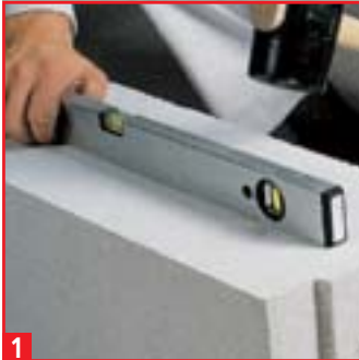
1 Ausrichten der ersten Schicht
