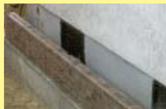
Für die Aufmauerung der Verblendschale sind die Bestimmungen der DIN 1053-1 maßgebend.
