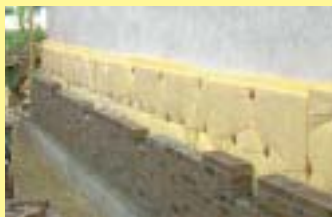
Weiche Dämmstoffe sind für Sanierungsmaßnahmen besser geeignet als harte Platten, da sie bei unebenen Untergründen flexibler und hohlraumfrei zu verarbeiten sind.
