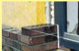
An allen Kontaktflächen zwischen beiden Schalen sind ausreichend dicke Dämmstreifen entsprechend der DIN 4108 Bbl 2 einzulegen.
