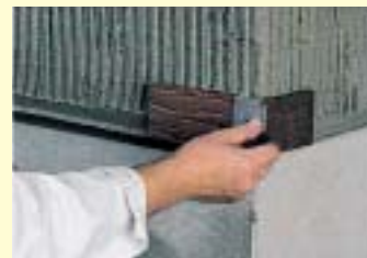
An allen Gebäudeecken werden Winkelriemchen eingesetzt.
