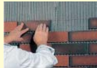
Die Riemchen werden im Floating-Buttering-Verfahren verklebt.
